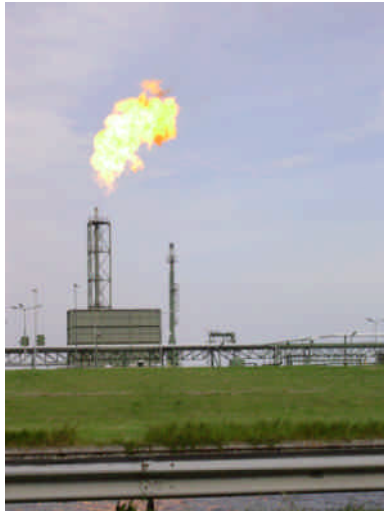
Figuur 1 Affakkelen van gassen, fossiele brandstofopslag in Den Helder bron: AMeces
